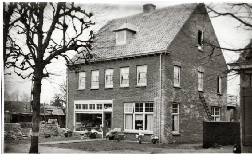
Slagerij Inkenhaag wederopgebouwd. 1941.
