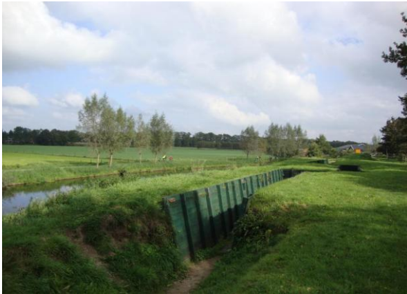
Liniedijk langs het Valleikanaal, 2011
