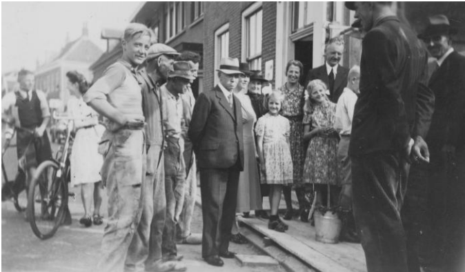
Eerstesteenlegging van het herbouwde huis door Hans Wensink (rechts nog net zichtbaar in witte blouse). Dokter Wensink, zijn vrouw en de twee oudste dochters kijken toe.
