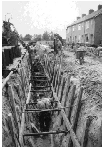
Aanleg riolering Nieuwstraat, 1960.
