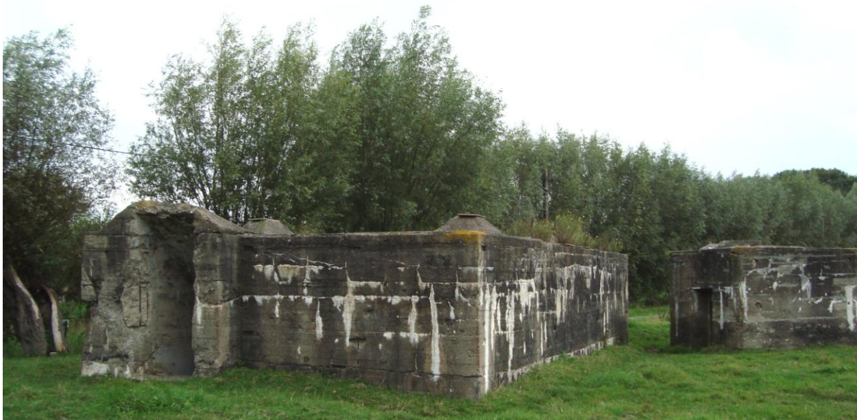
bunker 51.245746, 3.399556, verblijfsruimte met mitrailleurpost (re); uitvoering Marine, in gewapend beton
